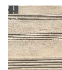
STAIR NOSING REFERENCE N.T.S.
